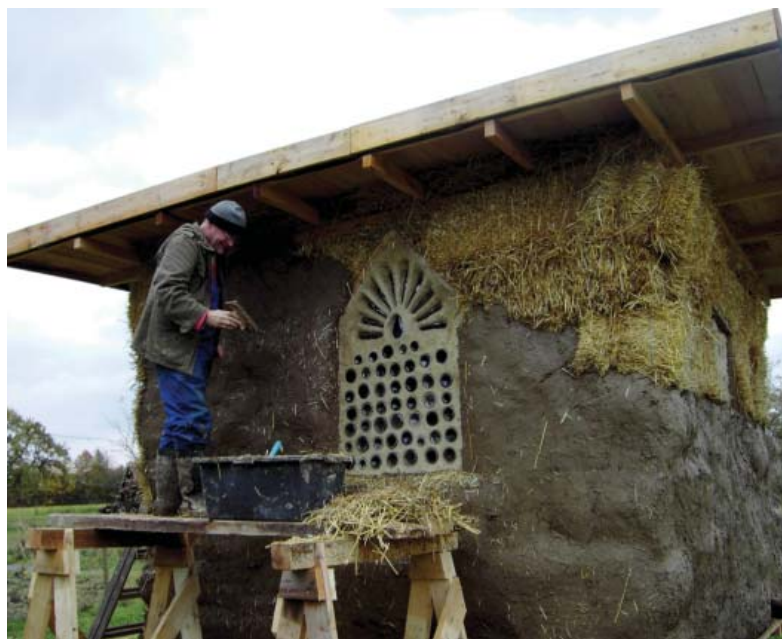
Wesentlich ist bei Strohballenbau, dass ein hoher Eigenleistungsgrad möglich ist.
