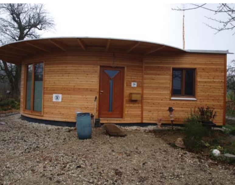
Strohballenbau ist ökologisch tragfähig und kann mit lokalen Baustoffen geschehen.
