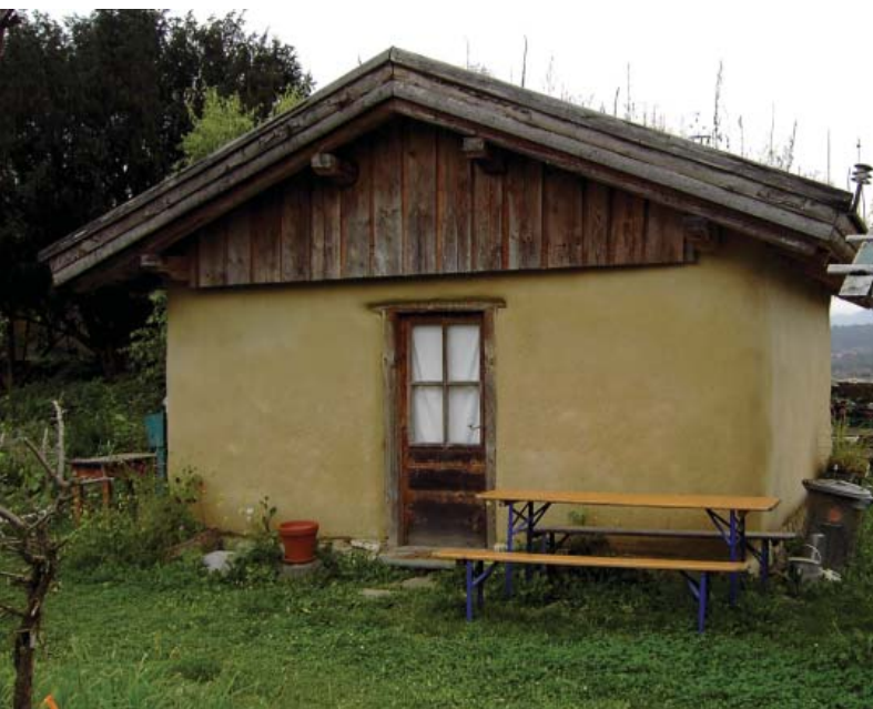
Einfaches lasttragendes Strohballenhaus mit Lehm verputzt und konstruktivem Schutz.
