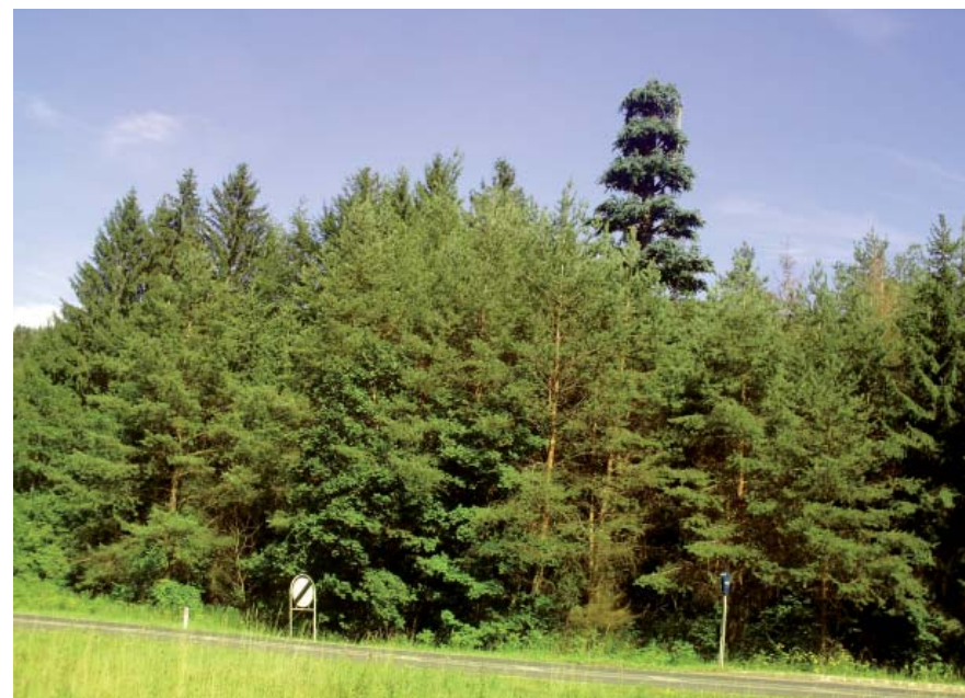
Dieser auffällige Nadelbaum in Kärnten erscheint nicht nur dem Forstmann, sondern auch dem Laien seltsam: In Wirklichkeit ist es ein Handymast, dessen Spitze mit Plastik-Nadelästen getarnt ist. Foto: G. Neuwirth
